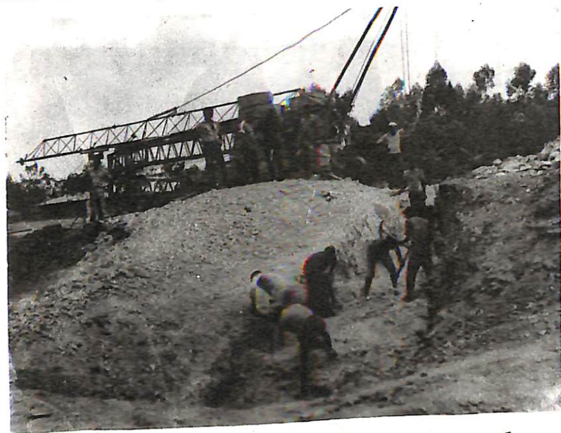
Vue des travaux de déblayage du canal d'amenée à Beni.
