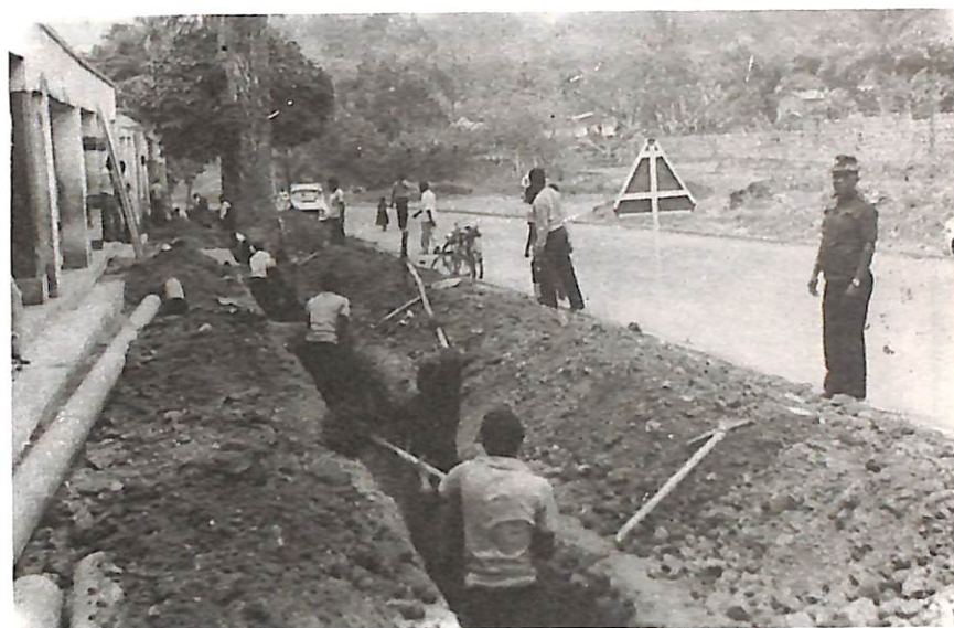
NPM : Les travailleurs à la tâche d'ouverture de la tranchée pour la pose des conduites.
