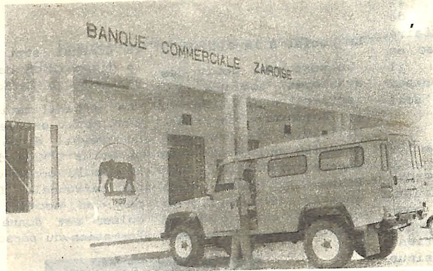
Depuis 1909 au service du Zaïre
